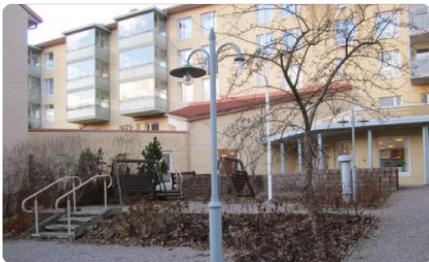
Kuvat 61 ja 62: Kaiteet ovat tarpeellisia kaltevalla kulkureitillä ja portaissa.
