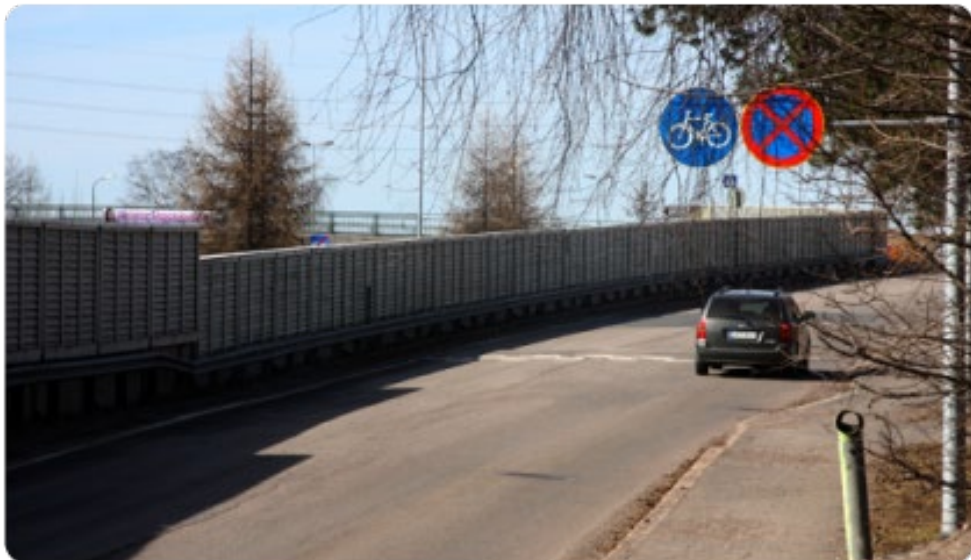
Kuva 89: Meluaita voi vähentää meluhaittoja ja parantaa siten turvallisuutta, sen pintaan voidaan asentaa esimerkiksi ritiläverkkoa köynnöskasvillisuutta varten miellyttävyyden lisäämiseksi.
