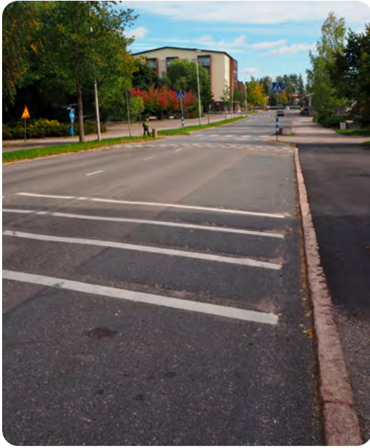
KUVA 15. Hidastetöyssyt, suojatien korotus ja ajoväylän kavennus suojatien kohdalla parantavat kävelyturvallisuutta.
